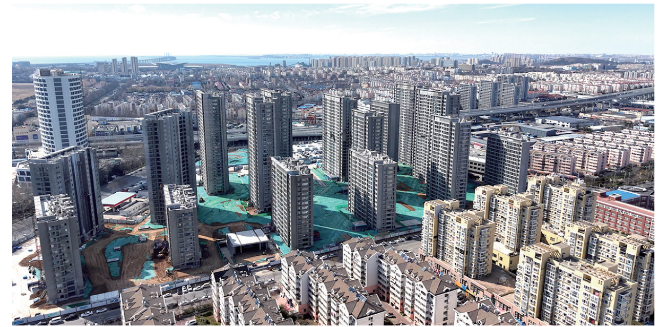
■李沧区京口路配建型保障性住房项目建设现场。
