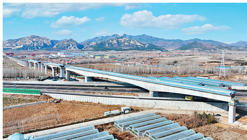
■潍宿高铁至青岛连接线项目建设现场。
