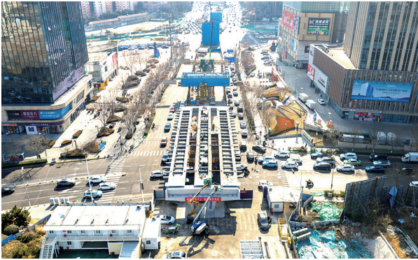
■双山隧道及南延配套工程首跨钢箱梁成功架设。
