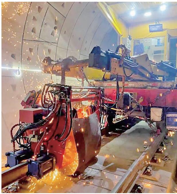
■新能源焊机亮相2号线二期铺轨工程。
