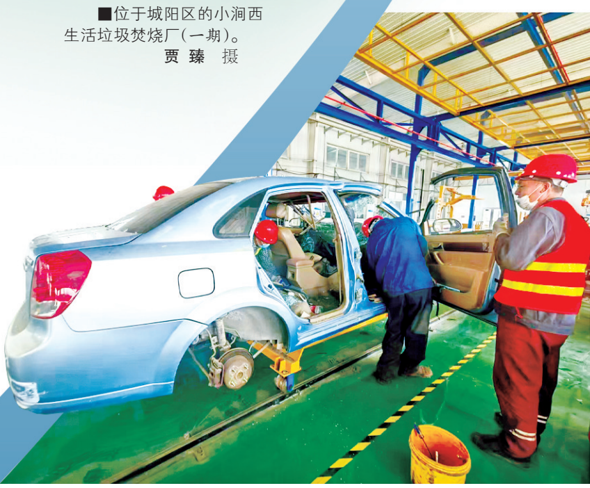
▲报废汽车经过拆解分类处置，可实现资源化利用。 梁超 摄
