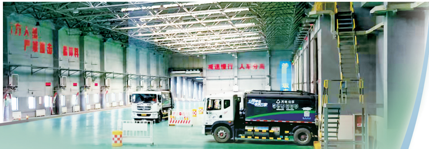
▲生活垃圾由封闭垃圾运输车送到处理厂。 梁超 摄
