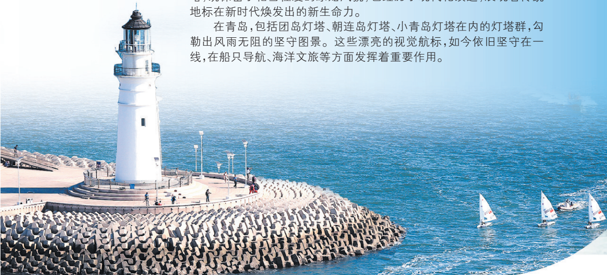
■奥帆灯塔已成为青岛市主城区地标性建筑之一。
