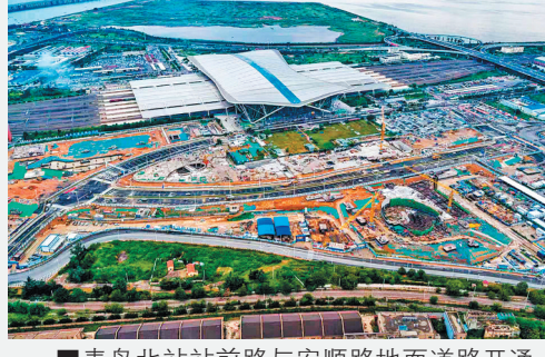
■青岛北站站前路与安顺路地面道路开通。
