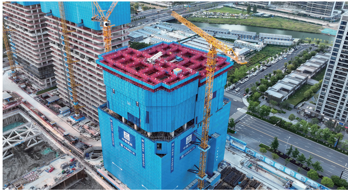
■天蝉3.0系统现场施工图。
