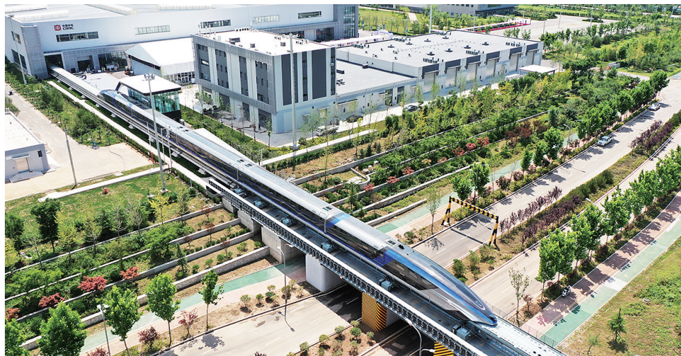
中车四方拟新建的千米长高速磁浮实验平台线路,将与既有时速600公里高速磁浮调试线并行。图为时速600公里高速磁浮试制中心园区。(本报资料照片)
