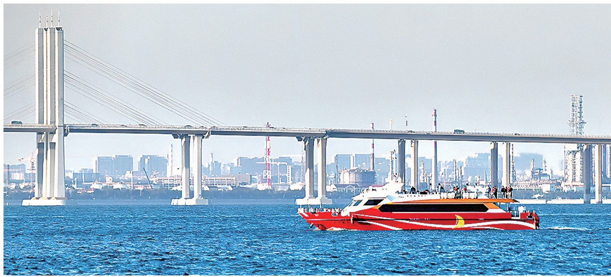
■东大洋“海上穿越大桥”航线带来冬游新玩法。 王雷 摄
