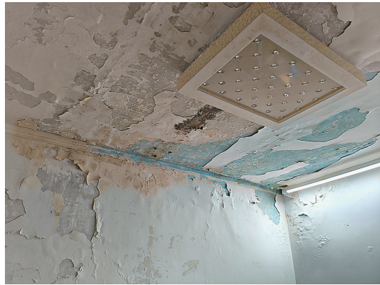
■颐和苑小区227号楼604户客厅的墙皮大面积脱落。
