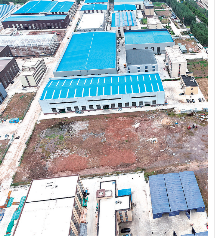
■青北智能制造产业园智能仓储设备制造项目总投资达1.2亿元。
