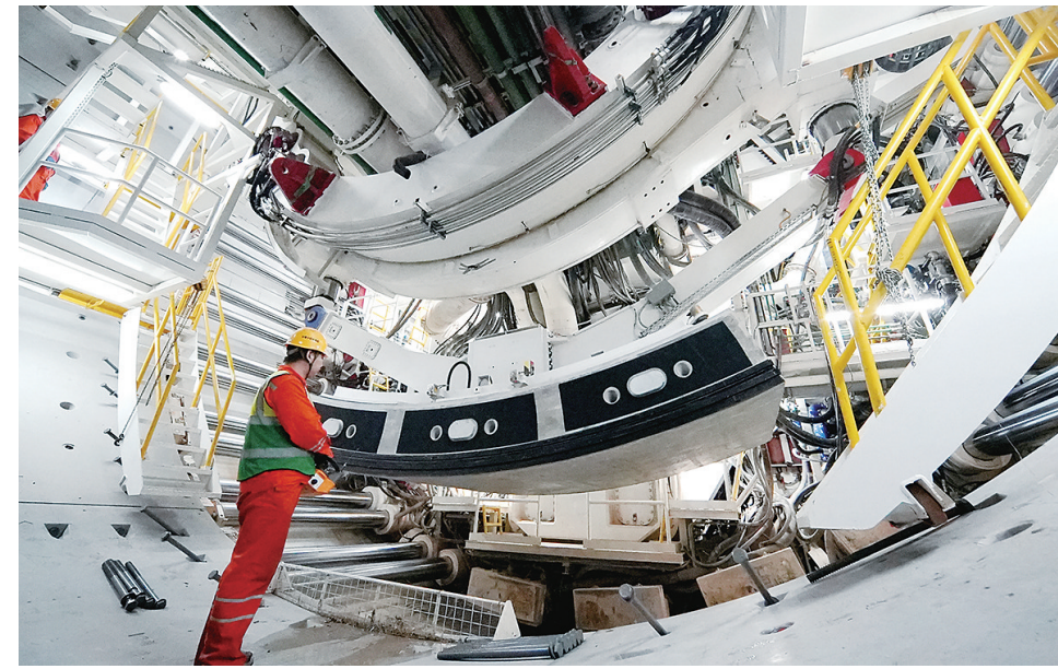
■胶州湾二隧项目管片拼装人员操作技能考核现场。
