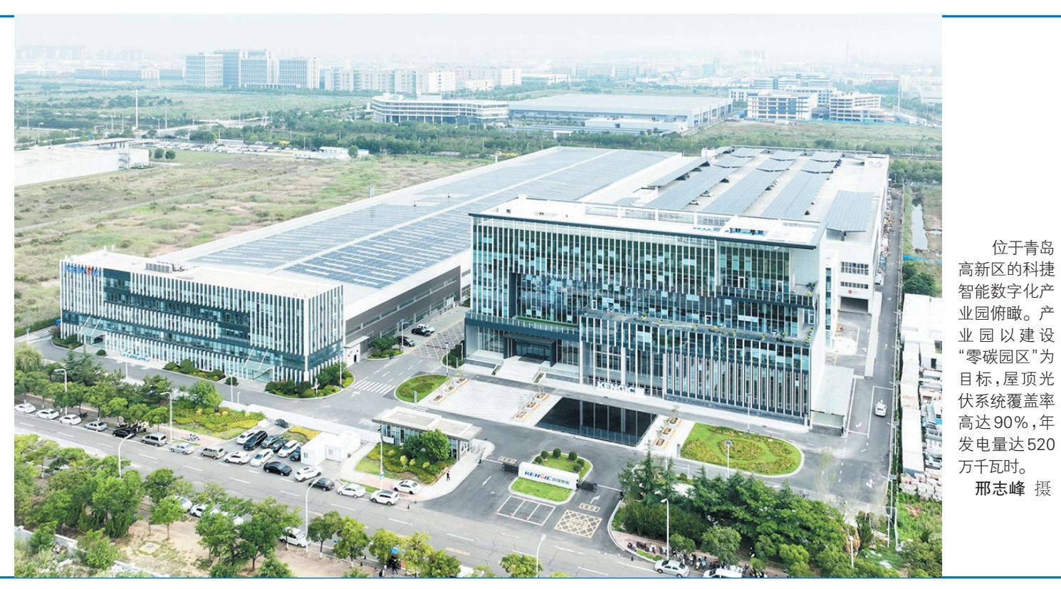
位于青岛高新区的科捷智能数字化产业园俯瞰。产业园以建设“零碳园区”为目标,屋顶光伏系统覆盖率达90%,年发电量达520万千瓦时。
