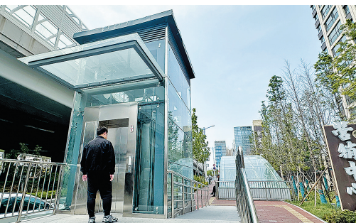
■东宸府小区门口地下通道的电梯已恢复使用。
