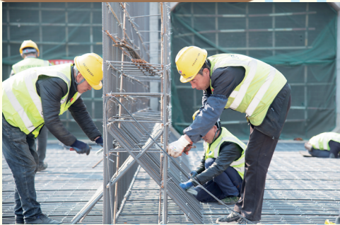
■施工现场，工人正在捆扎钢筋。
