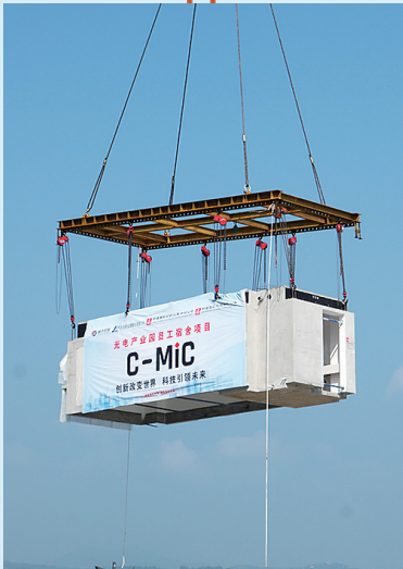
▲MiC预制建筑模块单元吊装现场。
