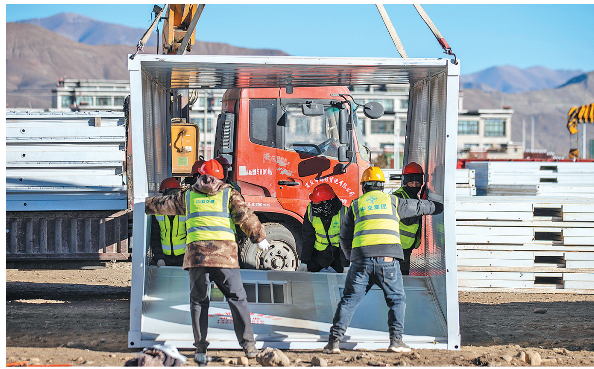
1月10日，工人在施工现场搭建活动房屋。新华社照片
