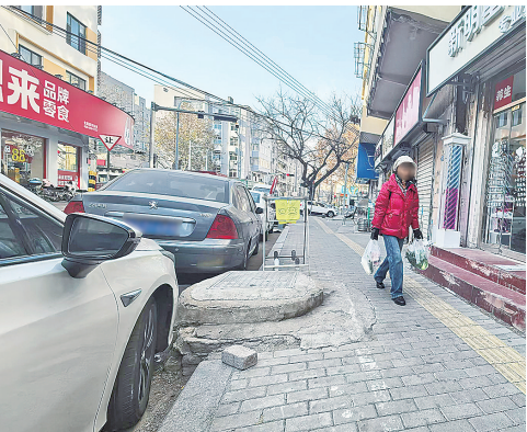
■阜新路北侧人行道上的一处检查井明显高出地面。
