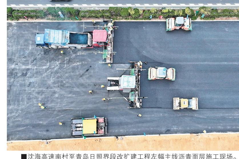
■沈海高速南村至青岛日照界段改扩建工程左幅主线沥青面层施工现场。
