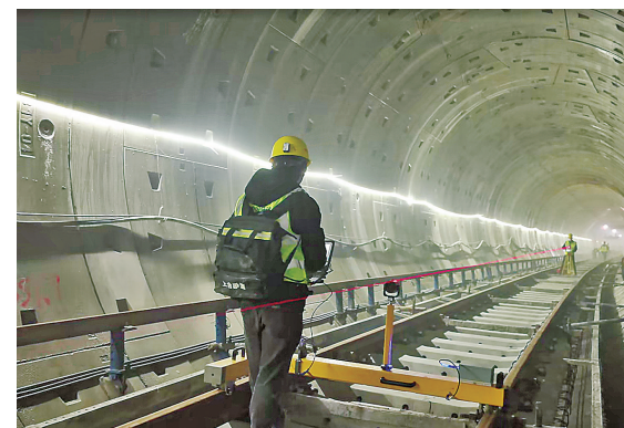
■地铁施工现场。
