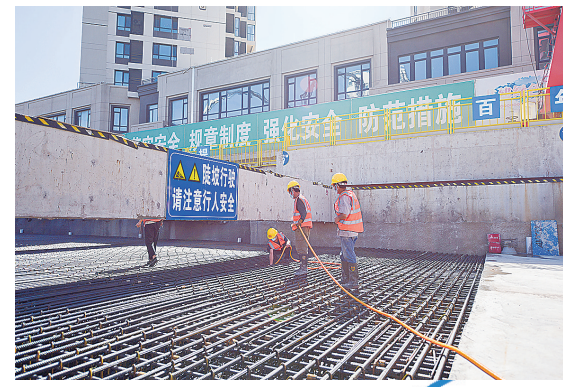
■2号线西延段轮渡站封顶。
