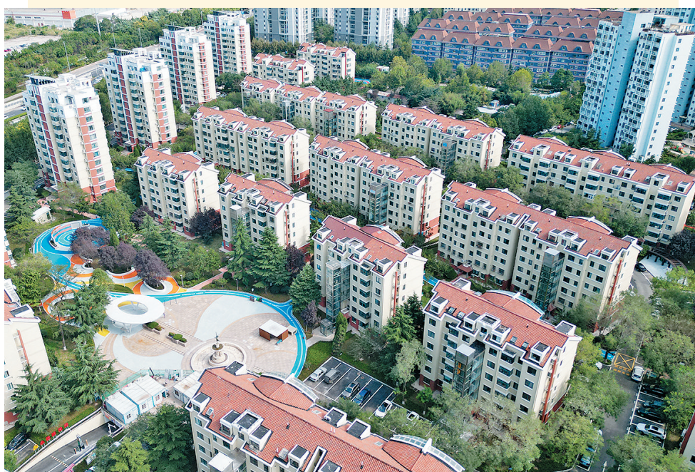
■经过更新改造，崂山区世纪华庭小区焕然一新。
