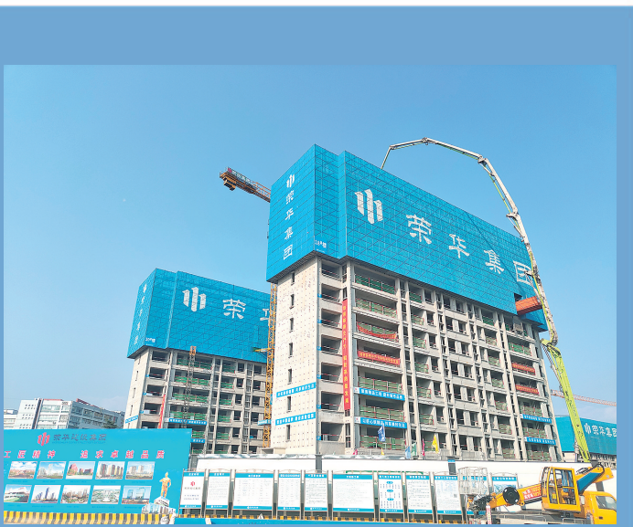
■ 张村社区村庄改造安置区建设项目。
