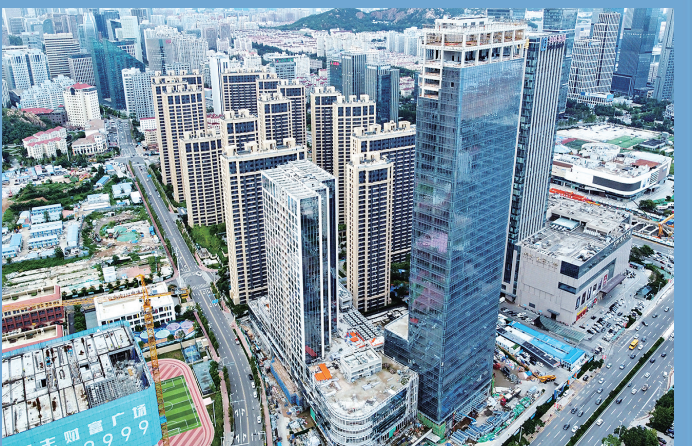
■ 山东头社区村庄改造项目LS0104-055地块（安置区）二期工程。
