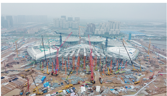
上合之珠项目建设时场景(摄于2022年)。邢志峰 摄
