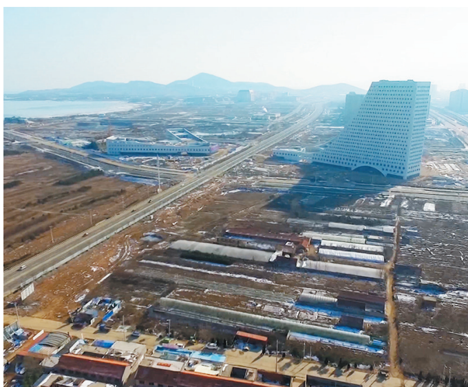
建设中的蓝色中心周边一片空旷。(摄于2017年) 青岛蓝谷提供
