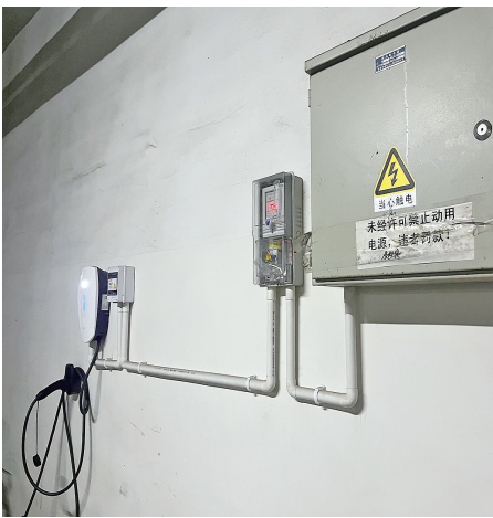
■东方华庭小区地下车库内安装了汽车充电桩。
