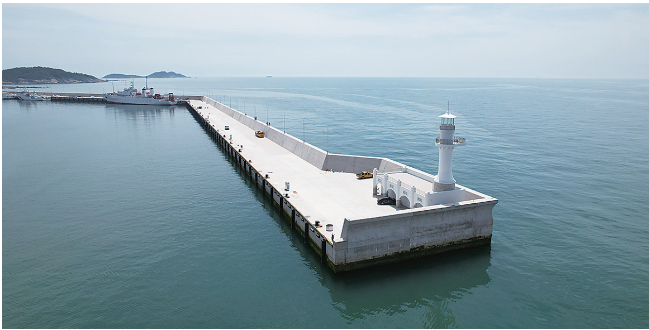
■位于崂山区的青岛海洋科考基地码头二期工程。
