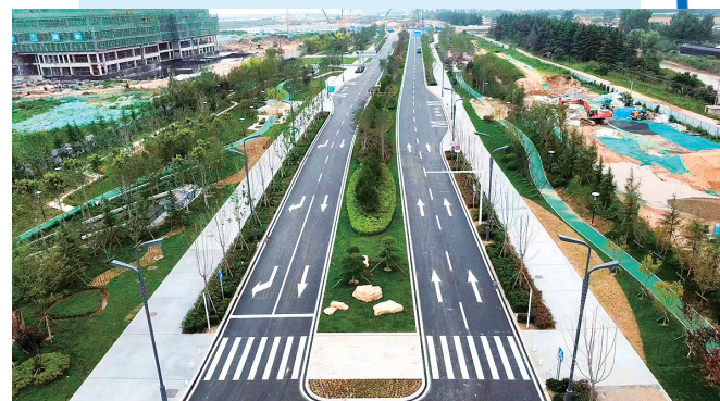
■位于青岛海洋生物医药产业园内的湾横4号线一期工程。
