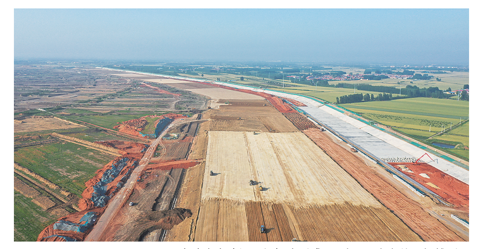
■官路水库建设现场初步形成2.5米至5米高的围坝雏形。
