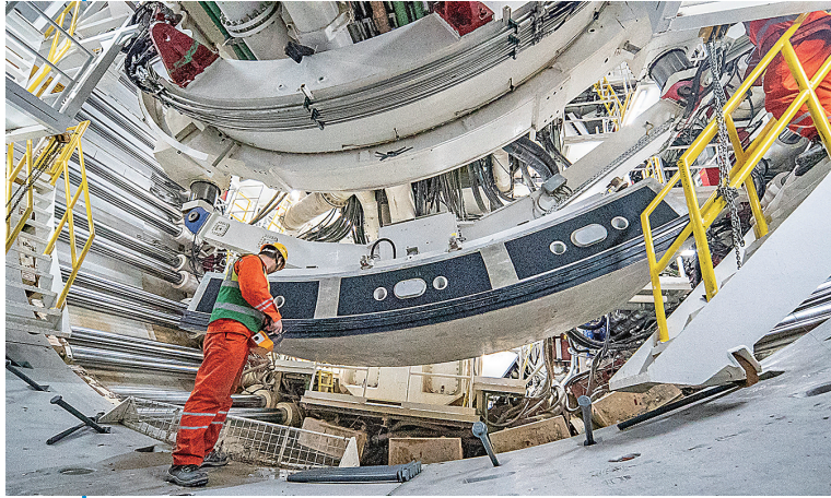
■在胶州湾二隧施工现场，工作人员在操作自主研发的盾构机。 刘栋 摄
