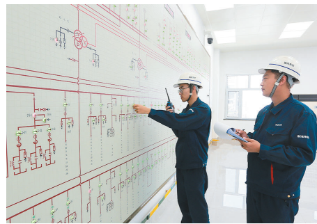
海湾化学电气部工作人员正按调度令实施送电操作。
