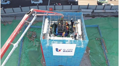
■新建匝道桥首根墩柱完成混凝土浇筑。
