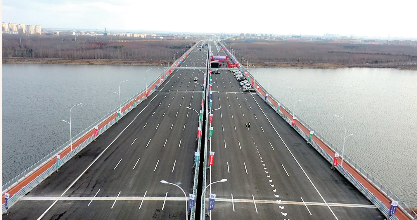
■国道204大沽河特大桥工程提前完工。
