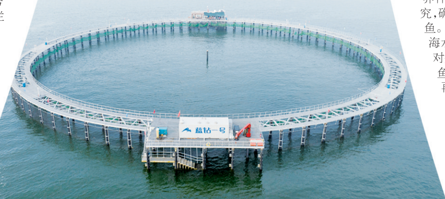
■我国首座深远海大型管桩养殖围栏“蓝钻1号”。
