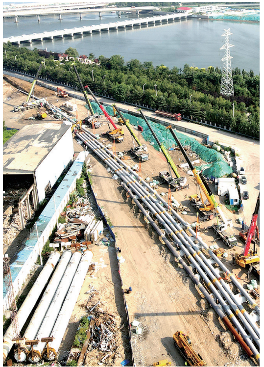
■胶州湾海底天然气管线项目的长管线在800吨推管机和海上作业船舶协同作业下,实现陆海连通。
