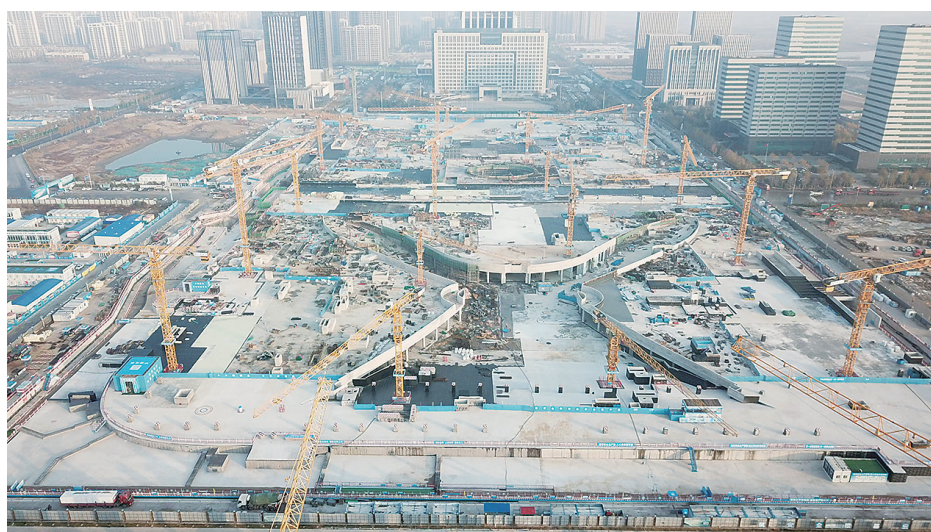
上合广场项目建设现场。
