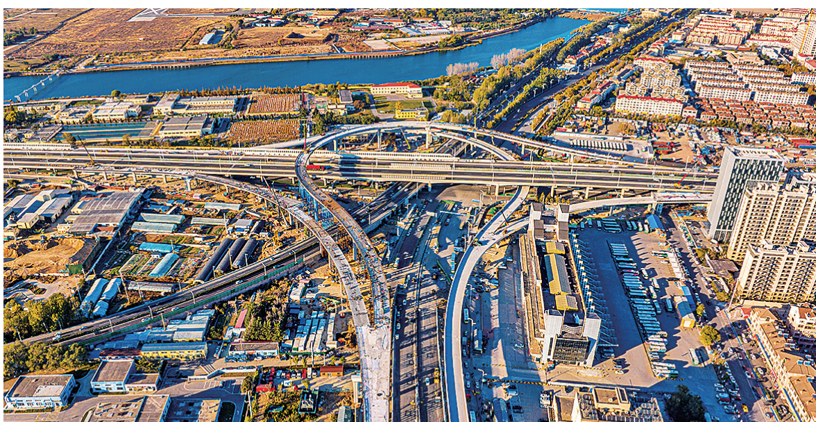
仙山立交顺利贯通,将与重庆路快速路工程主线同步通车。
