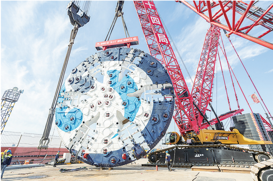
■“海天号”盾构机刀盘正在吊装下井。
