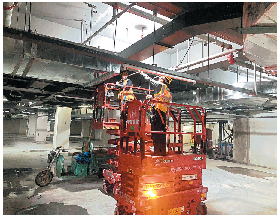
■施工人员正在开展地下空间车位引导屏穿线施工。
