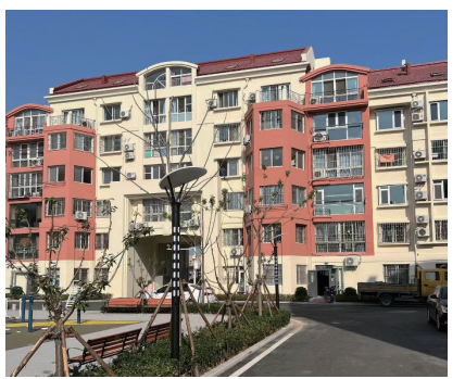
改造后的圣富花苑小区。
