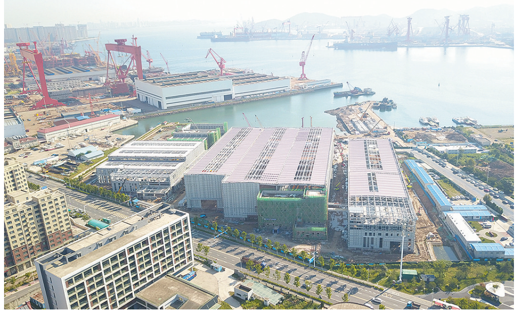
潍柴(青岛)海洋装备制造中心项目加快建设。
