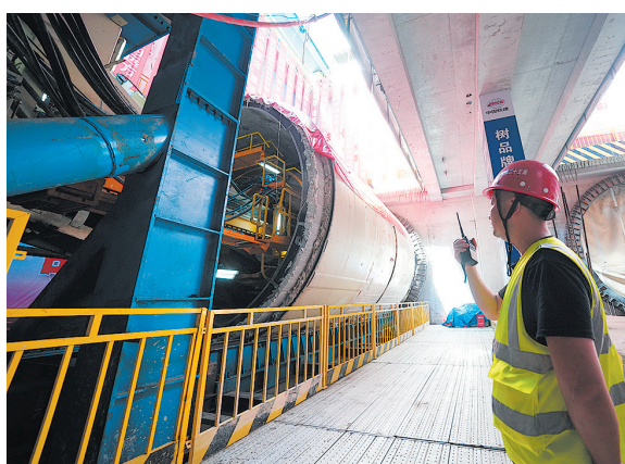
■地铁2号线二期首台盾构机“入地”掘进。
