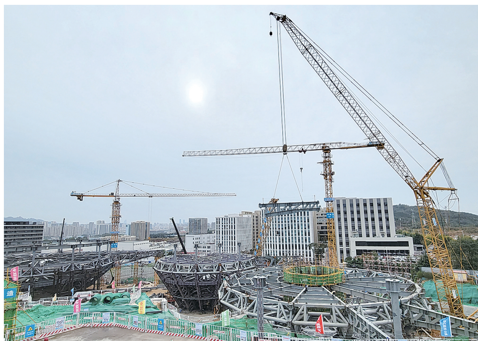
■青岛虚拟现实创享中心项目正加速推进钢结构施工。
