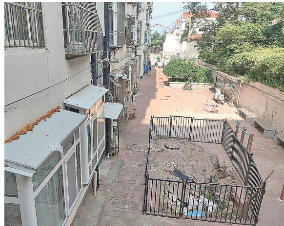
■ 佛涛路11号居民楼前的电梯基坑内管道纵横。
