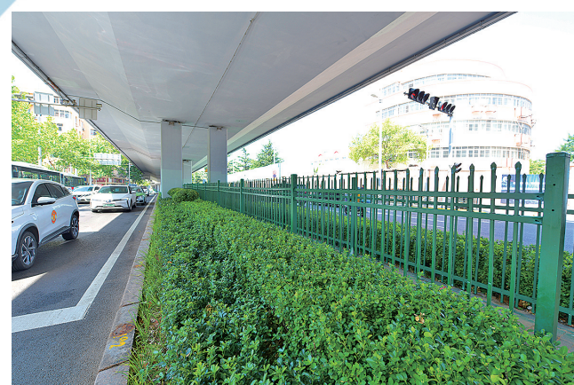
■胶宁高架桥下延安路、延安一路路段。
