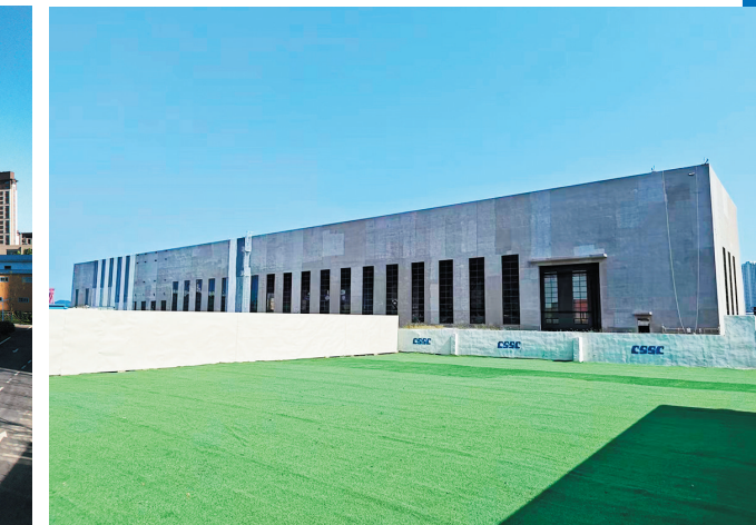
■中船集团712所海西湾基地项目。
