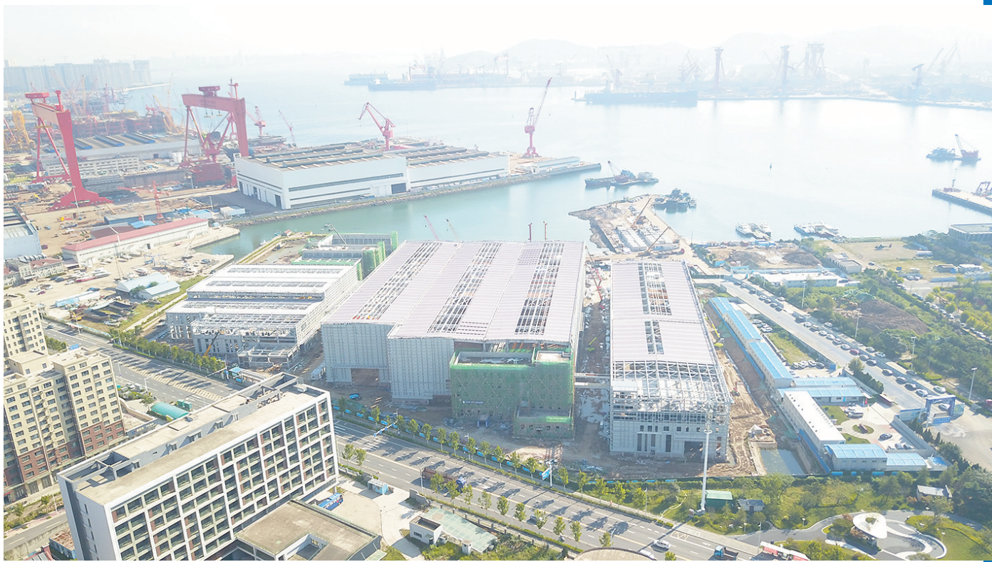
■潍柴（青岛）海洋装备制造中心项目。
