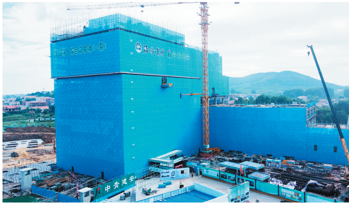
■青岛海上综合试验场项目。
