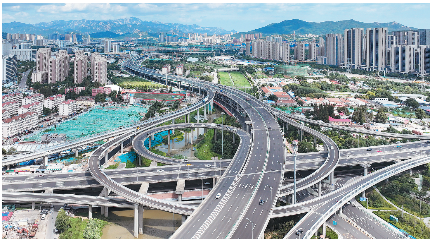
纵横交错的跨海大桥高架路一、二期交会处。
