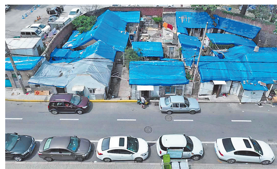
■市南区泰州路片区(整治前)。
