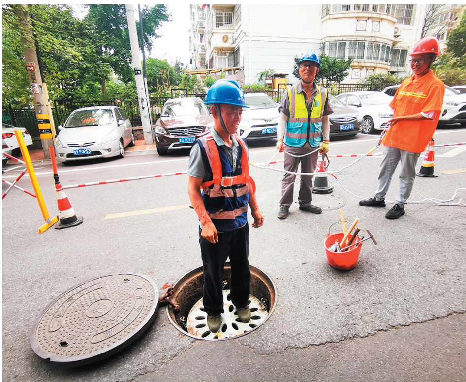
■工作人员检测防坠隔板的承重效果。
