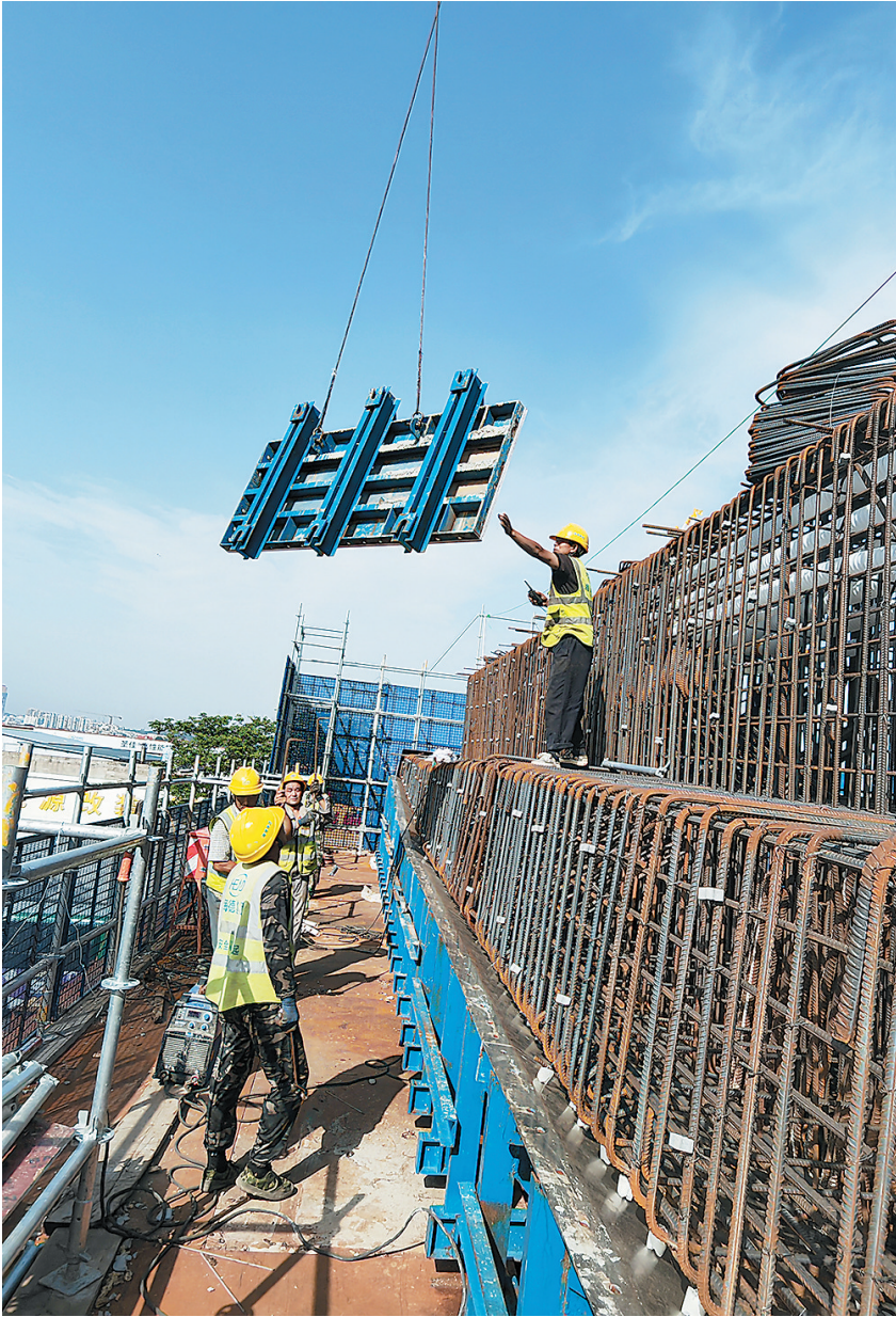
▲ 重庆路快速路工程现场,施工人员头顶烈日安装侧模板。
