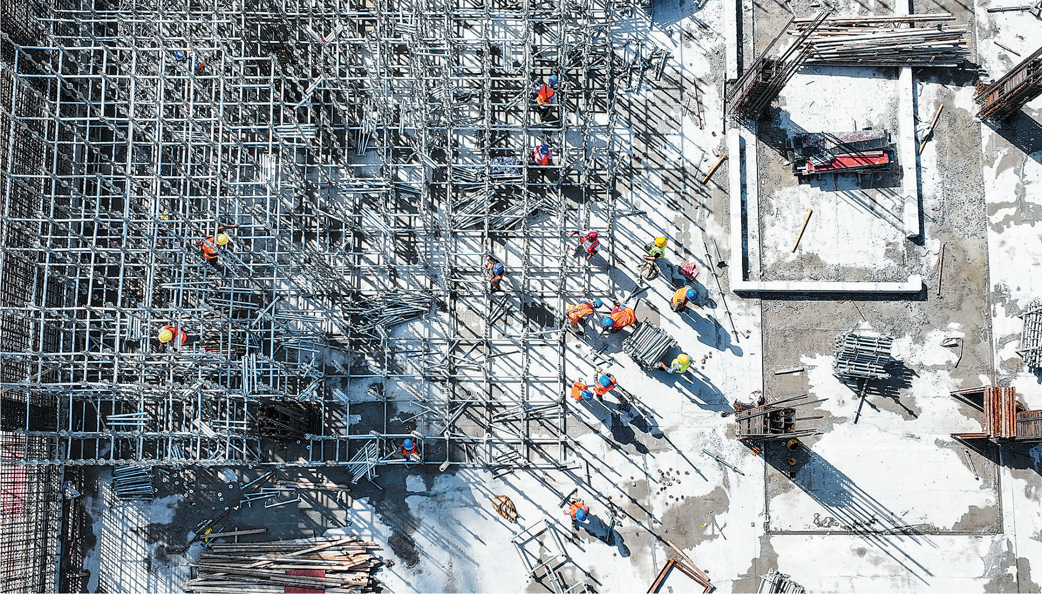
■ 海尔路-银川路立交工程现场的施工人员在烈日下搭设脚手架。
