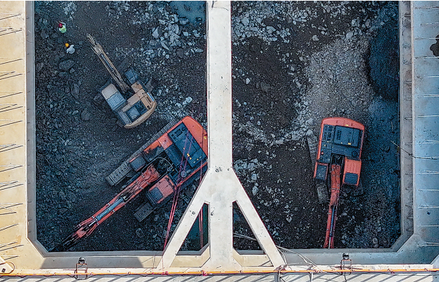
■ 挖掘子在地铁2号线常川路车站进行轨排井施工。
