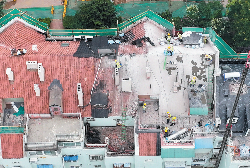
▼ 在市南区湛山街道秀港路社区,施工人员正在对老旧小区实施屋顶防水作业。
