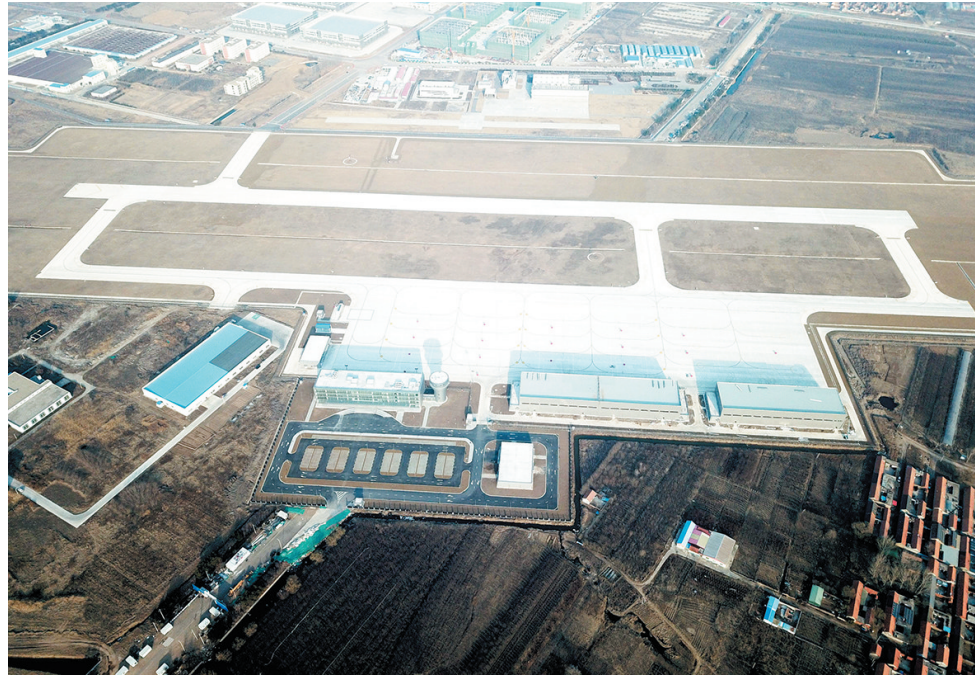
■即墨华山机场工程完工。
